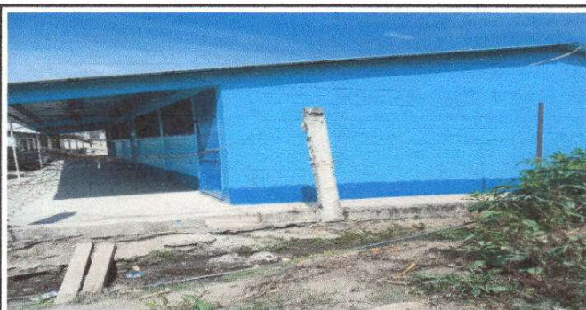
Foto 5: Reparación de muro perimetral y malla
