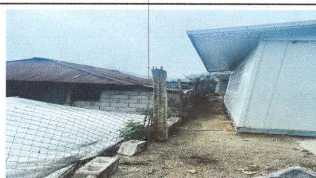
Foto 6: Reparación de muro perimetral y malla
