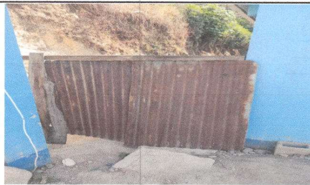
Foto 2: Sustrucción de portones de metal
