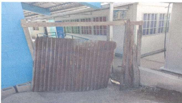
Foto1: Sustrucción de portones de metal
